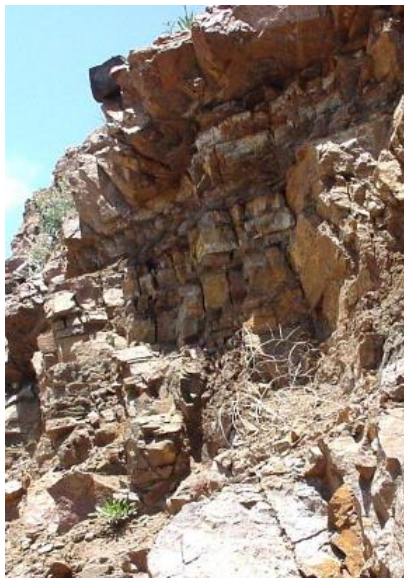
Слика 8.6: Полу-континуално осипање услед деградације стијенског материјала ( raveling )
